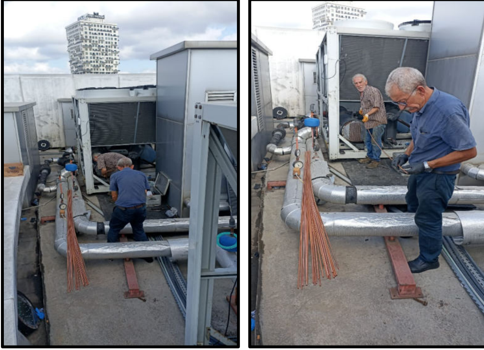
Belediye Ana Binası, Aşevi ve Erol Olçok Kültür Merkezi Chiller bakım ve onarımı yapılmıştır.
