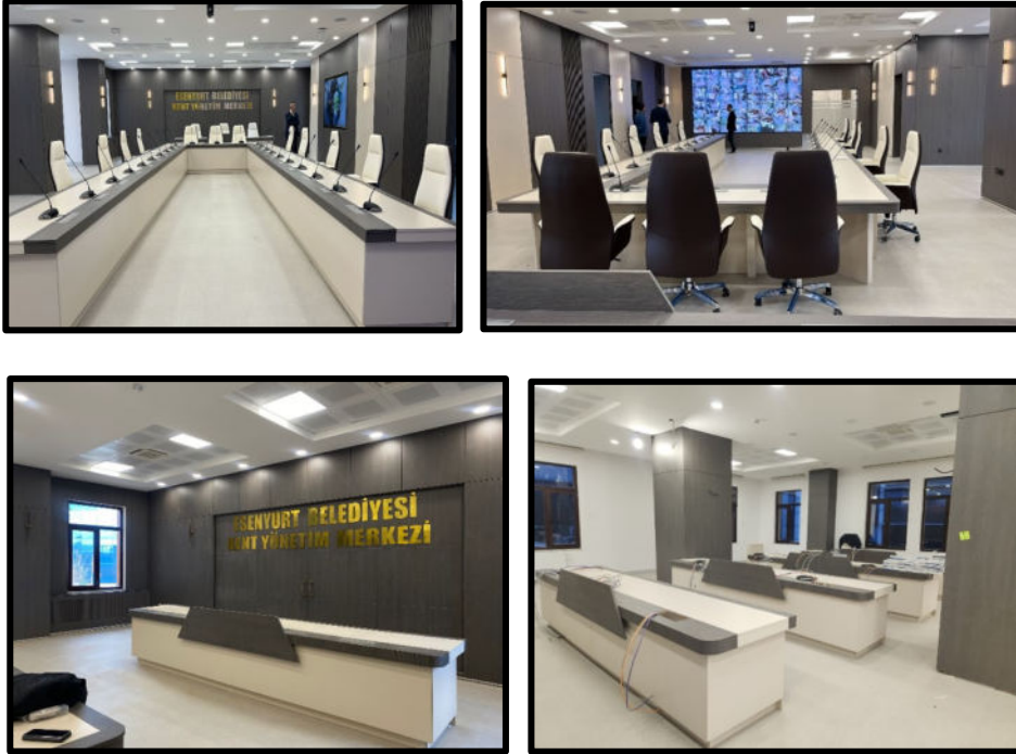
Eski Belediye Binası içerisinde Afet Kent Yönetim Merkezine duvar kaplaması, pvc zemin kaplaması yapılmış olup iç mekan mobilyaları alınmıştır. Tesisin komple elektrik, kamera ve ses sistemi işleri yapılmıştır.
